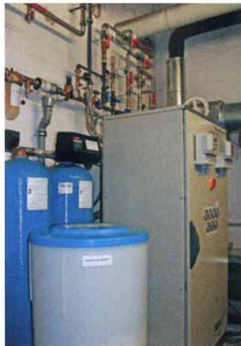
Das Wasseraufbereitungssystem findet auf kleinstem Raum im Keller Platz (li.). Osmosewasser sorgt im Spülbereich für fleckenfreies Geschirr und Besteck (re.).
